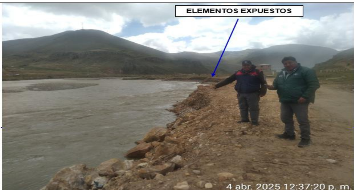
FIGURA N°01: TRAMO CRÍTICO EN EL RÍO RAMIS, DONDE SE EVIDENCIA LA EROSION DE LA RIBERA DEL RIO EN EL SECTOR HUANACOMAYO, DISTRITO DE SAN ANTON, PROVINCIA DE AZANGARO - PUNO.
